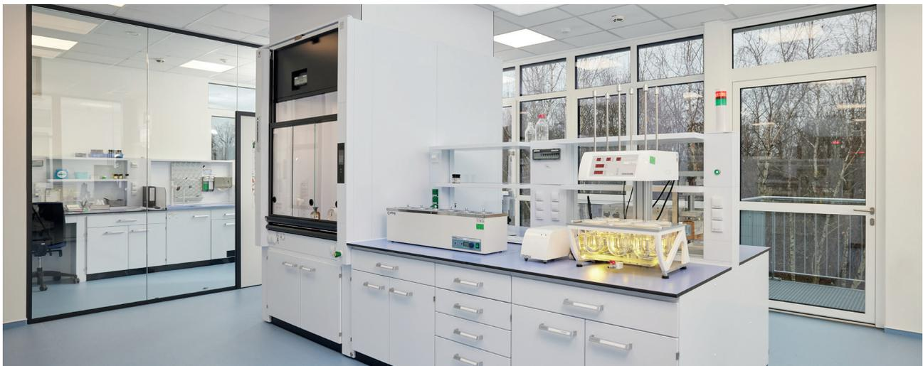
Ein innovatives **Luftkonzept** integriert die Köttermann Laborabzüge in die Lüftungs- und Temperaturregelung und trägt so zu einer gleichbleibenden Laborluftqualität bei. Damit erfüllen die Laborabzüge eine Doppelfunktion: Sie schützen nicht nur die Mitarbeiter bei kritischen Arbeitsschritten, sondern sorgen durch den Luftaustausch auch für ein gesundes Raumklima.
